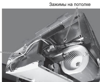
**⑤ Снятие балки и крышки электрического блока**
